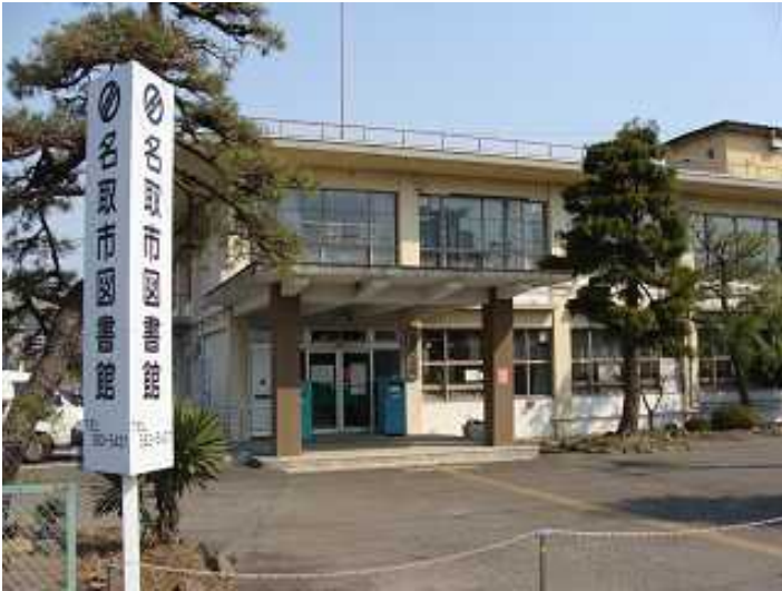
図書館全景（外目は被害が無さそうだが・・・）
