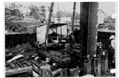
順調に進む夢のかけ橋 石狩河口橋工事
